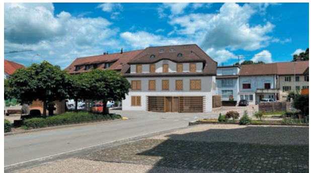
La visualisation montre à quoi pourrait ressembler un jour le centre d'accueil des visiteurs « Doppeltür » à Lengnau.
